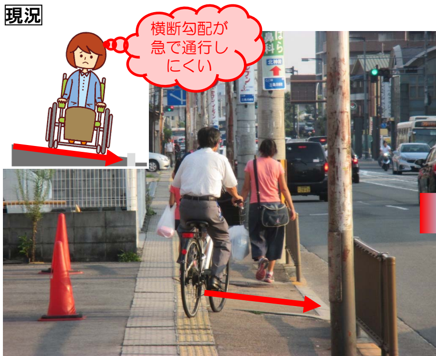
※対象区間東側歩道の状況
